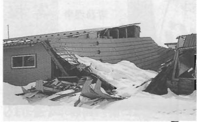
大雪になって、新聞等で建物が崩壊しているニュースが連日報道され、秋田県も豪雪対策本部を設置した等の報道がなされたので、雪の災害には充分に注意しておこうと作業員に敷地内全棟の雪降ろしを指示して、雪降ろしをさせていたが、丁度その雪降ろしの最中に「建物一棟の半分が崩壊」してしまった。幸い、作業員にけがが無かったことが1番の救いであったが、建物はもちろん、中の収容動産も使用不能となり、頭をかかえてしまった。
